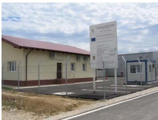
Fig.22 Stația de epurare ape uzate oraș Deta
